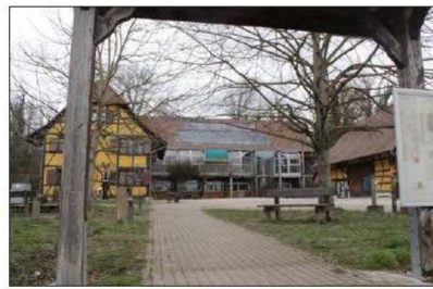
La Maison de la nature du Sundgau devrait prochainement subir une cure de jeunesse avec d'importants travaux de rénovation de tout le complexe. Archives L'Alsace/Vivian MILLET
